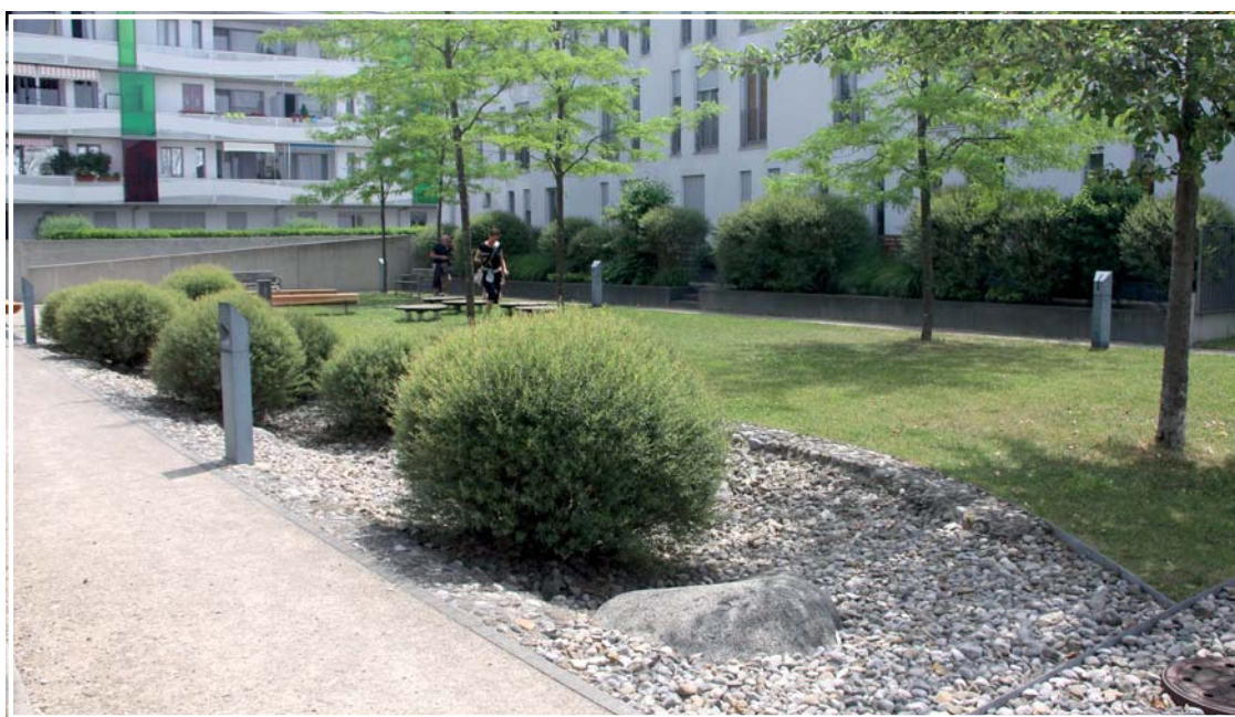
Štěrkový průleh tekoucí vodu zpomalí a dočasně ji zachytí před odtěčením ze svahu
